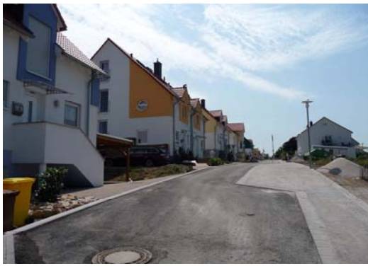
Die Anliegerstraße ist fertig gestellt
