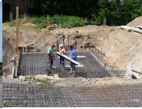
Baubeginn II. Bauabschnitt ist erfolgt
